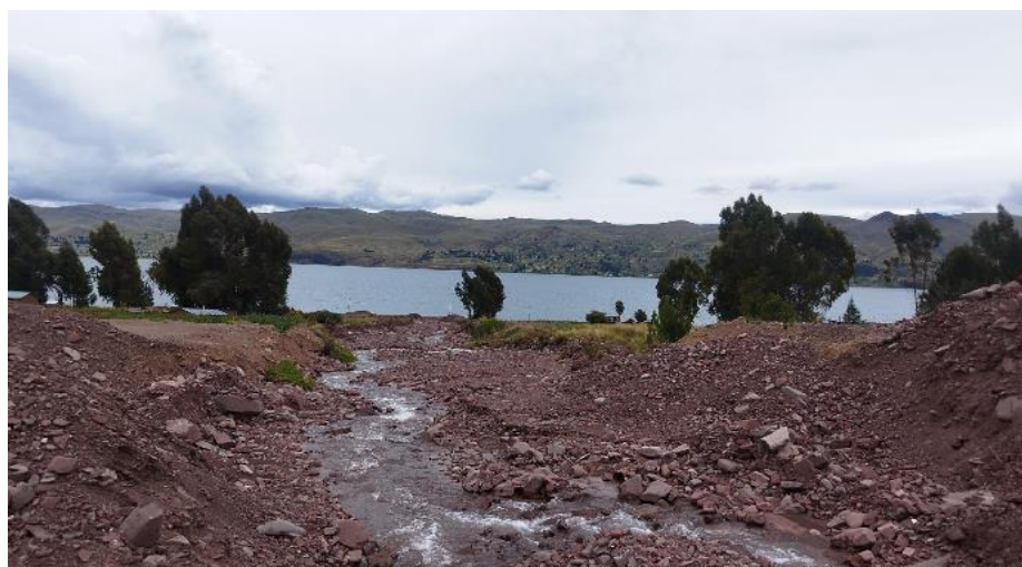
FIGURA N°03: EN LA TEMPORADA DE MAXIMAS AVENIDAS, LA QUEBRADA QUELLOCACA EN ESTE TRAMO DEL SECTOR, ARRASANDO CON TODO LO QUE SE ENCUENTRA A SU PASO, TAMBIEN SE APRECIA QUE EL CAUCE SE ENCUENTRA COLMATADO.
